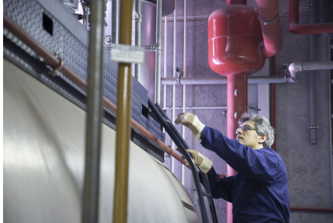
Mantenimiento de calderas.
