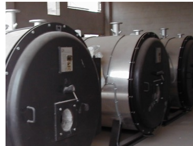
Frontales de la caldera pirotubular CBA.
