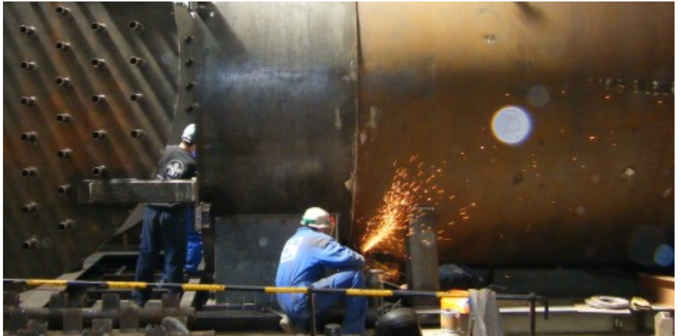
Mantenimiento de calderas.
