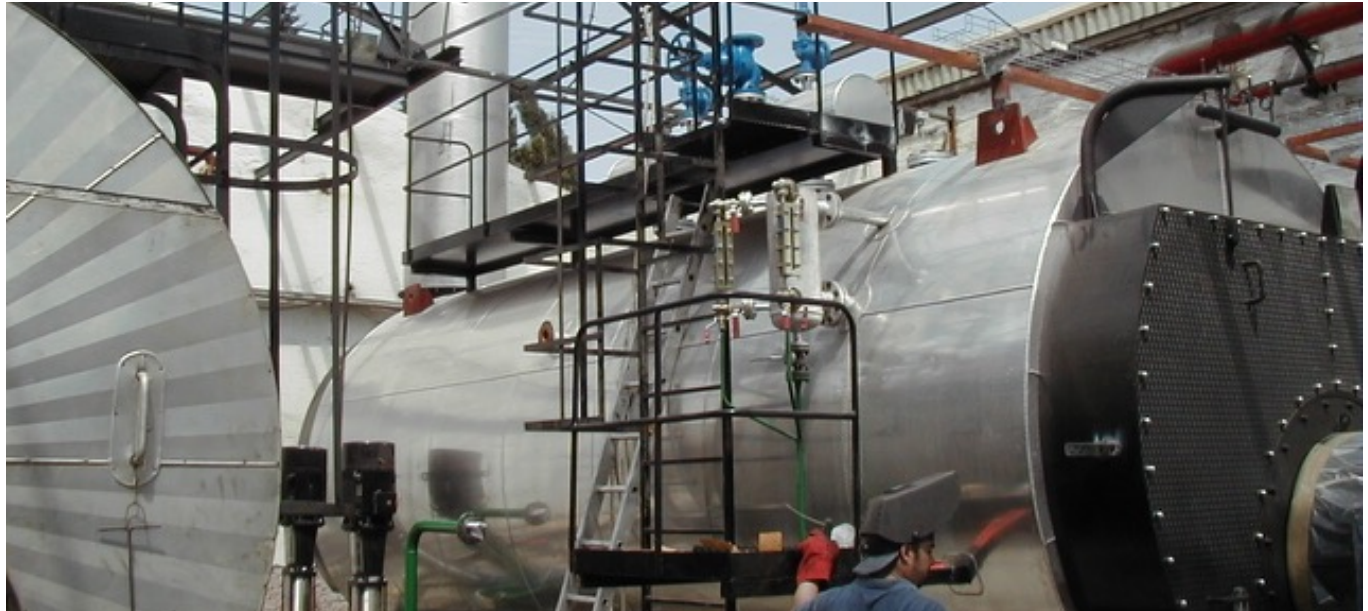
Instalación de calderas.
