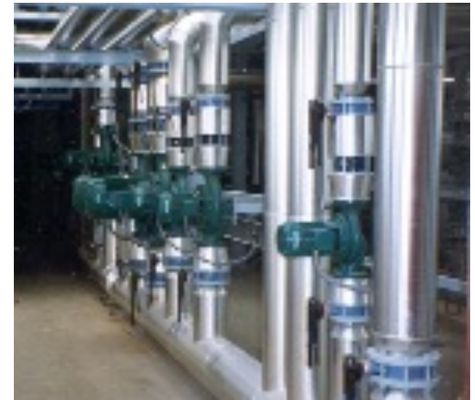
Instalación de conducciones.
