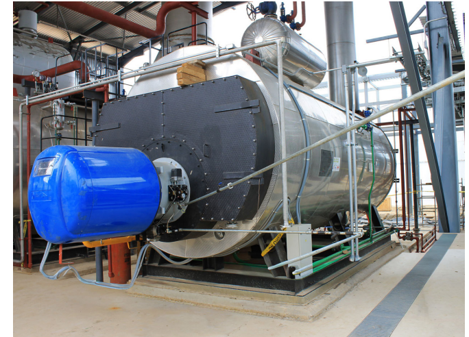
Frontal de caldera pirotubular de vapor GVL-H
